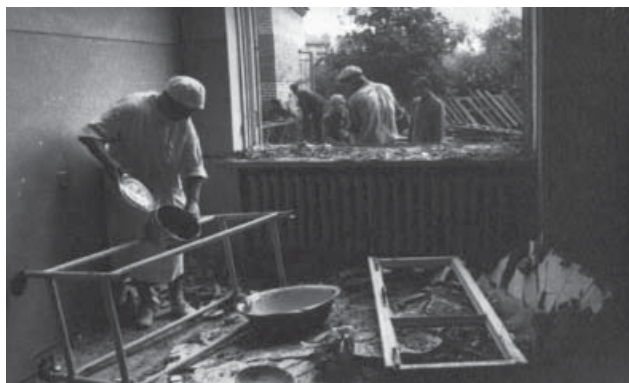
Рис. 2. Разрушение детской больницы. Москва. 1941 год Fig. 2. Destruction of children's hospital. Moscow. 1941
